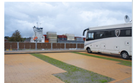
Neben jeder der 33 gepflasterten Stellflächen liegt ein schmaler Grünstreifen.
