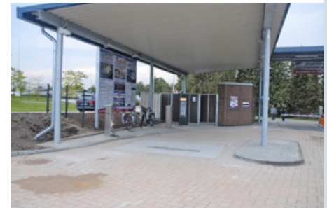
Die Einfahrt sowie die Ver- und Entsorgungsstation sind komplett überdacht.
